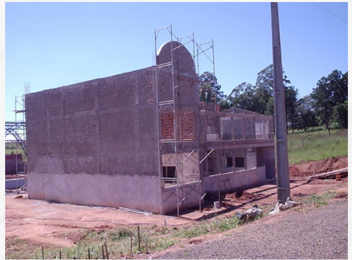
Construção do Prédio 1
