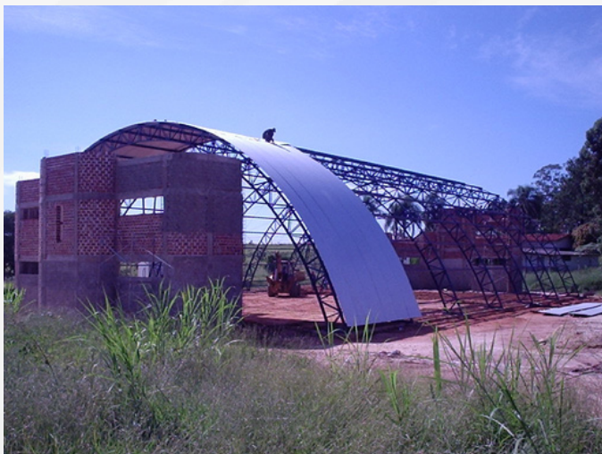
Construção do Ginásio de Esportes
