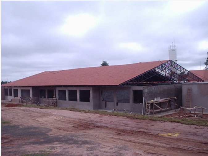
Construção do Bloco C
