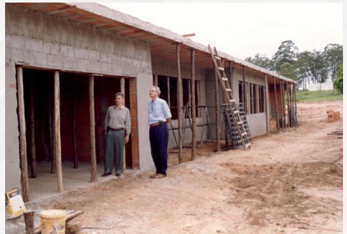
Construção do Bloco B
