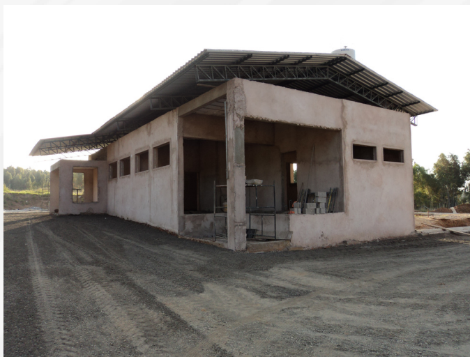
Construção do Prédio 3
