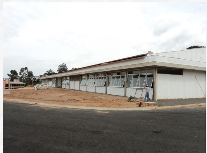
Construção do Prédio 2
